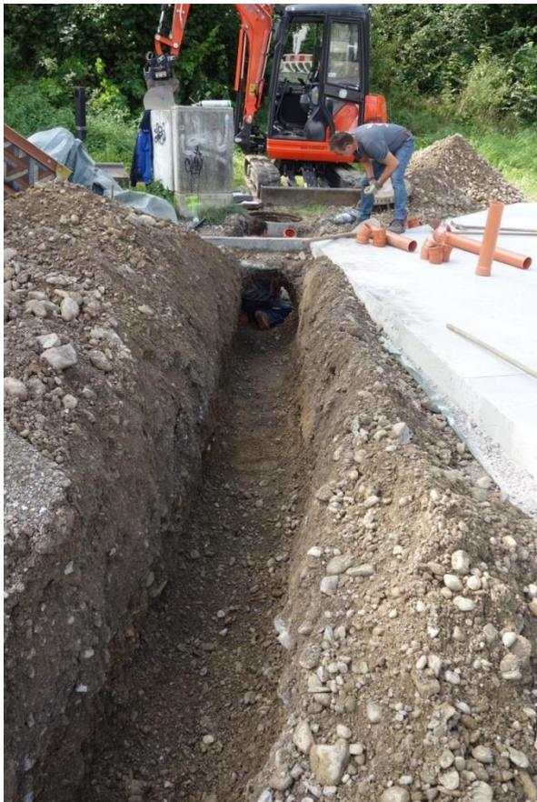
Durch die Verlegung eines Abflusses aufgrund einer Senke am 22. konnte die restliche Fläche erst am 7. September betoniert werden.
