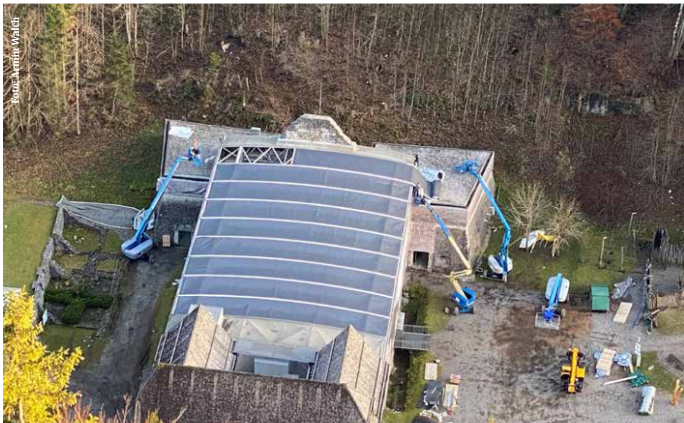
Montage des neuen Membrandaches bei der Arena Ehrenberg
