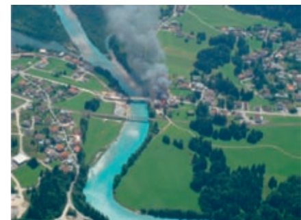
Gebäudebrand in Pfäfers
